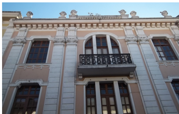
Figura N° 4. La fachada del edificio rematada con sus respectivas cráteras. Foto del autor
