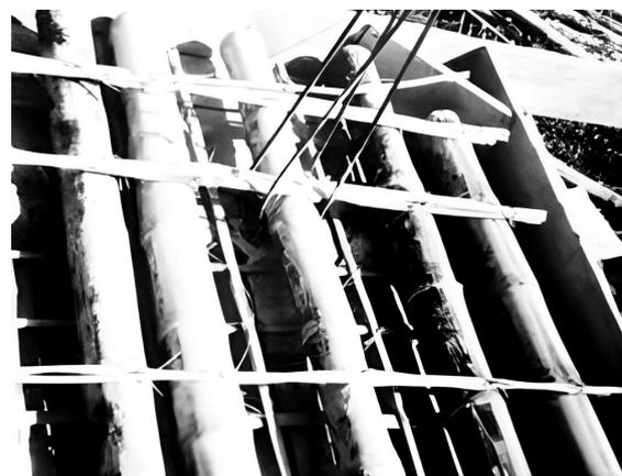
Figura 8. Cables trenzados, malla inferior, caña rolliza.
