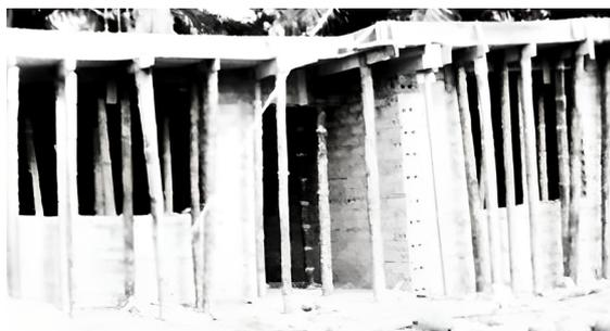
Figura 13. Encofrado
