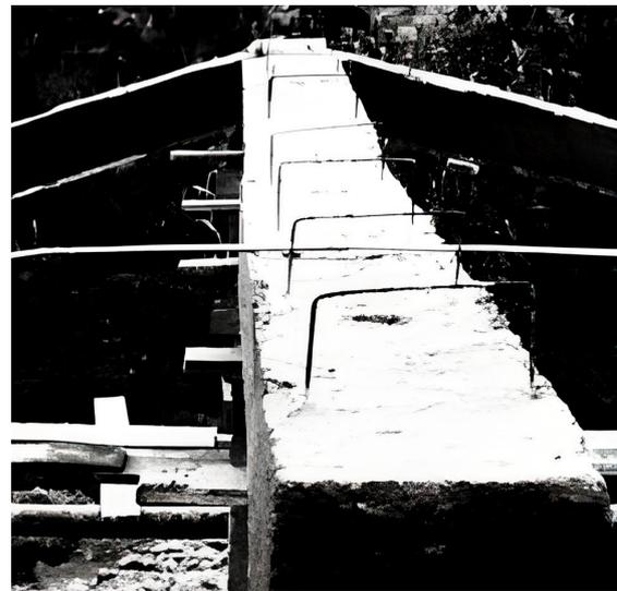
Figura 5. Estribos para anclaje de losa
