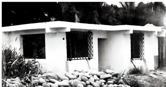
Figura 14. Casa con cubierta de losa con caña guadua embutida en hormigón.
