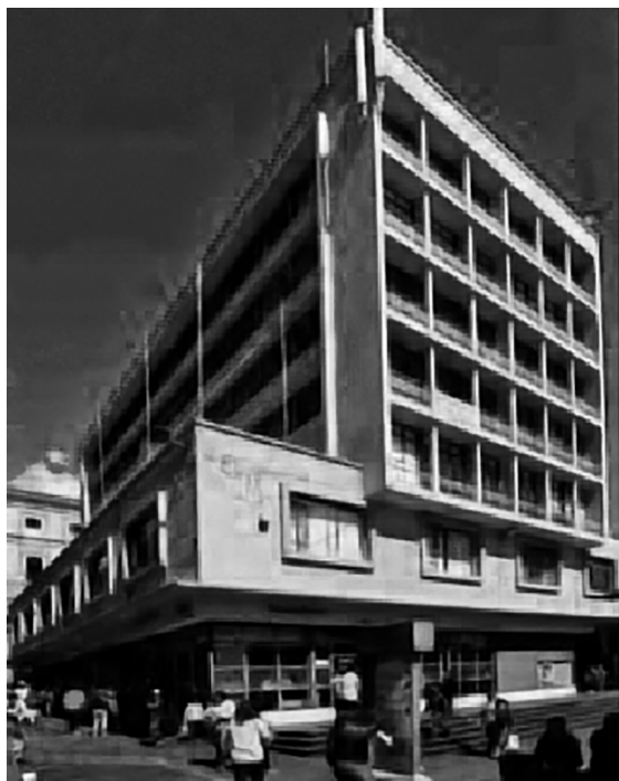
Figura 39: Edificio Guerrero Mora por el grupo ARQUIN. En la esquina de las calles Chile y Guayaquil. Lenguaje racionalista con una concepción estética y sin ornamentos. Tipología Torre plataforma; con un basamento horizontal y un bloque vertical de 5 pisos. Introdujo un nuevo lenguaje de materiales y técnicas constructivas. La planta baja es de uso comercial, vidriada y cubierta por un voladizo. Composición horizontal con ventanas corridas, referentes del estilo corbuseriano.
