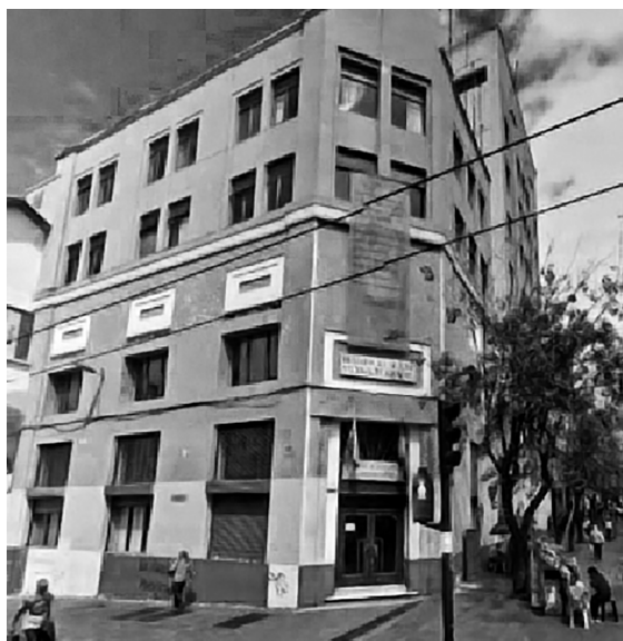
Figura 40: Edificio La Previsora (Hotel Humbolt) por los arquitectos John Hopkins y Dentz. En la esquina de las calles Espejo y Guayaquil. Es el primer edificio en altura de Quito. El conjunto se compone de tres cuerpos: El volumen bajo de cuatro pisos y dos bloques en altura. Las fachadas expresan un lenguaje moderno, sin decoración, formas geométricas puras en las ventanas y molduras. Introdujo una nueva tecnología estructural y constructiva. Uso de hormigón armado, muros de ladrillos, pisos de baldosas y las modernas instalaciones eléctricas y mecánicas. Edificios en Altura, Nuevas oportunidades de la era petrolera. Los edificios en altura se disponen sobre las avenidas principales, Av. Patria, Amazonas, 10 de Agosto.
