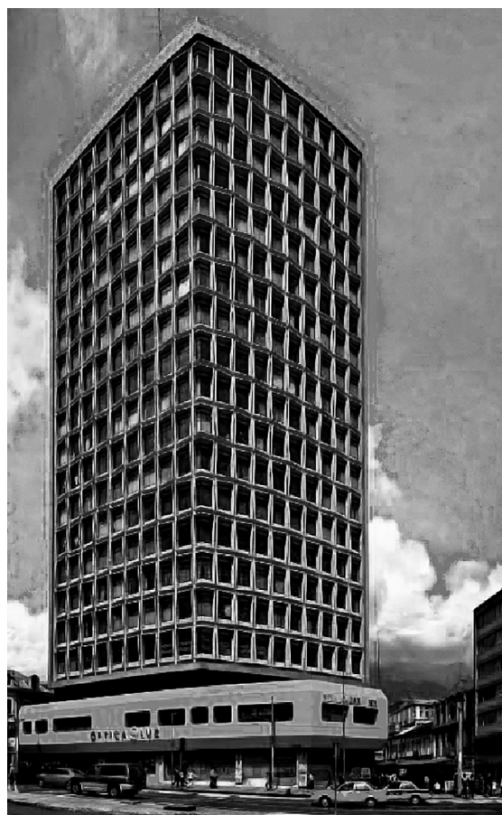
Figura 42: Plano texturado conformado por elementos prefabricados de hormigón. Elementos que se repiten en la fachada dando la sensación de movimiento. Edificio Benalcázar 1000, 1971. Arquitectos Najas, Flores, Rosero. Ubicado en la esquina de la Av. 10 de Agosto y Riofrío es Punto referente de la ciudad y la puerta al Centro Histórico.
