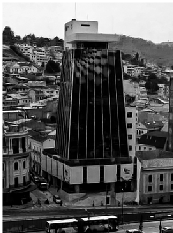
Figura 41: Curtain wall o muros cortina, es una característica de los edificios en altura como una piel de vidrio. Predominio del hormigón estructural y formal. Composición equilibrada en las fachadas. La Filantrópica, 1970. Arq. Diego Ponce
