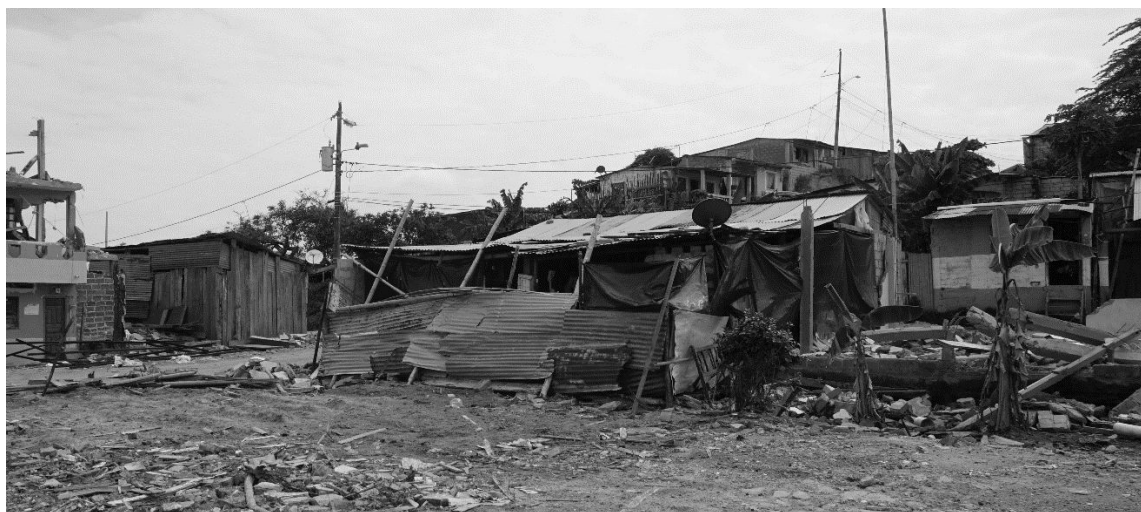
Figura 6. Vivienda espontánea sobre solar propio aprovechando los restos de la edificación preexistente. Fuente: Daniele Rocchio y Ricardo Moya, 2016.
