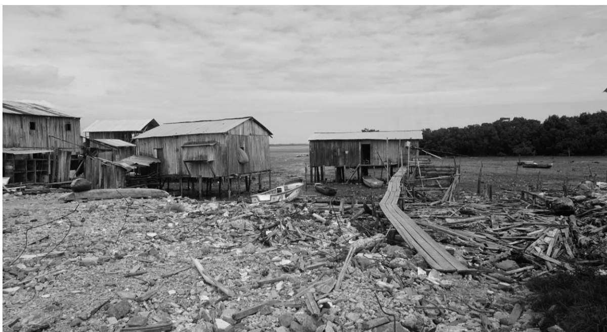
Figura 3. Edificaciones vernaculares de San José de Chamanga.
