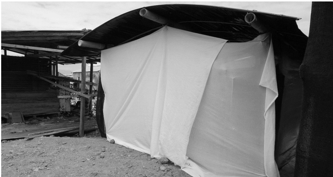
Figura 15. Vivienda con tecnología constructiva en caña guadúa, insólita hasta la fecha. Un año después del sismo.
