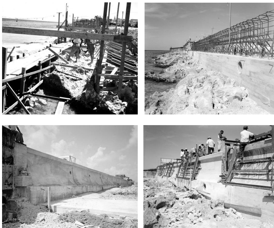
Figuras 4, 5, 6 y 7. Desde la imagen superior izquierda se establece el ciclo del proceso constructivo del segundo tramo del Malecón de La Habana. (Britinho, 2010, 27 de diciembre).
