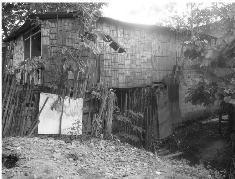
Figura 1. Vivienda construida sobre el cauce de un estero (se observa en la parte inferior de la fotografía el cauce y la forma de la vivienda ahuecada) en el sector de Cruz María, Quevedo.
