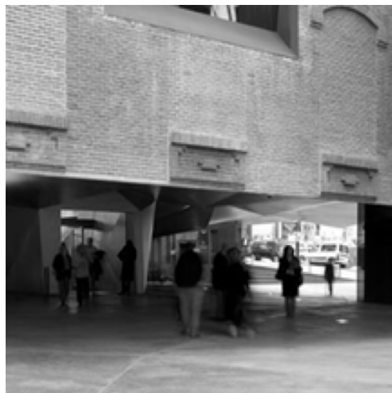
Figura 4. Vista ingreso exterior. Ausencia muro. Fuente: https://divisare.com/projects/16682-herzog-de-meuron-duccio-malagamba-caixaforum-madrid
