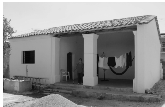
Figura 8. Tipologías de viviendas reconstruidas posdesastre en Ixtepec. Vivienda tradicional reforzada por asociación civil (60 m 2 -120 m 2 , muros de ladrillo cocido, muros de carga, tizón y soga, techo tejavana, cocina y baño interior, optativo).
