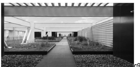
Figura 9. (a9, b9) Plataforma Gubernamental de Gestión Financiera. foto: D.A. (c9,) Terraza de la Plataforma Gubernamental. Foto: Oswaldo Rivera
