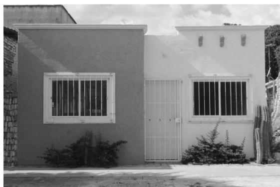
Figura 5. Tipologías de viviendas reconstruidas posdesastre en Ixtepec. Vivienda llave en mano de constructora. (30 m<sup>2</sup>-50 m<sup>2</sup>, altura 2.5 m-3 m, muros de block, estructura de castillos y trabes, techo losa de concreto, cocina y baño interior). Fuente: Elaboración Propria
