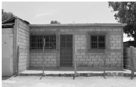
Figura 6. Tipologías de viviendas reconstruidas posdesastre en Ixtepec. Vivienda autoproducida por habitantes. (60 m<sup>2</sup>-120m<sup>2</sup>, muros mixtos block y ladrillos, estructura de castillos y traves, techo de losa, baño y cocina interior, optativo)
