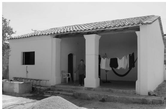
Figura 8. Tipologías de viviendas reconstruidas posdesastre en Ixtepec. Vivienda tradicional reforzada por asociación civil (60 m<sup>2</sup>-120 m<sup>2</sup>, muros de ladrillo cocido, muros de carga, tizón y soga, techo tejavana, cocina y baño interior, optativo).
