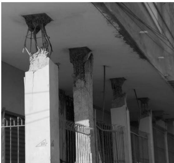
Foto 5. Deficiente separación de estribo en cabeza de columna.
