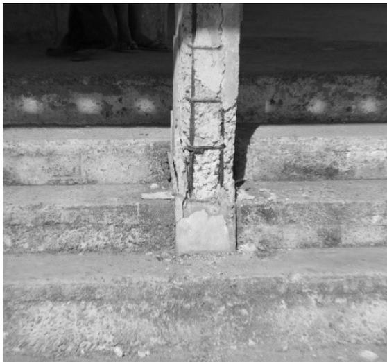
Foto 4. Deficiente separación de estribo.
