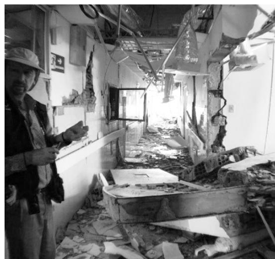
Foto 3. Hospital IESS de Manta internamente. Se visualiza daño en mampostería
