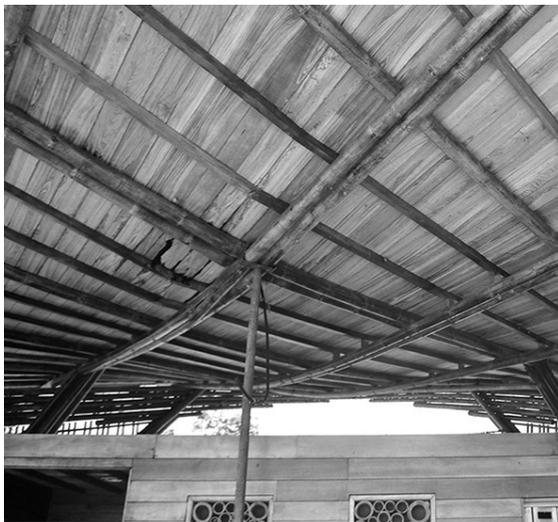
Figura 9. Apuntalamiento provisional de la cubierta por riesgo de colapso en febrero de 2020.
