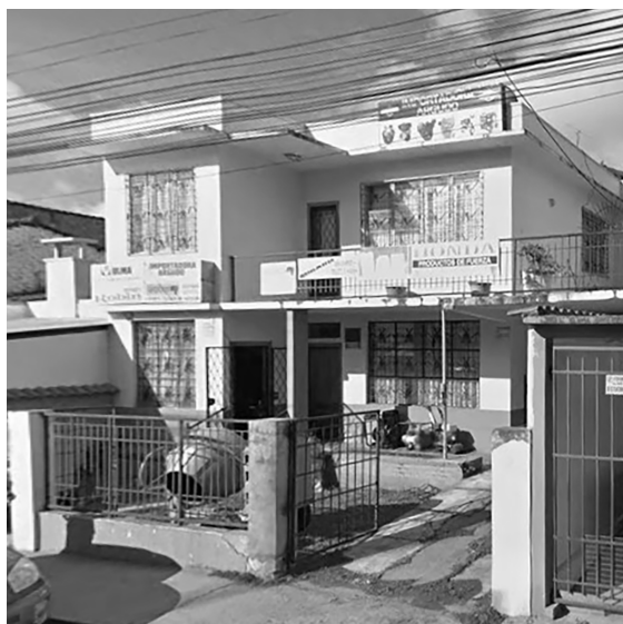
Figura 1. Fotografía casa Argudo. Fuente: Google maps.
