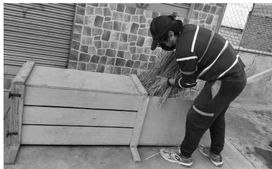
Figura 8. Colocación de la paja en el cajón de compresión
