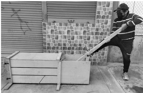
Figura 9. Compresión de la primera capa de paja introducida en el cajón principal
